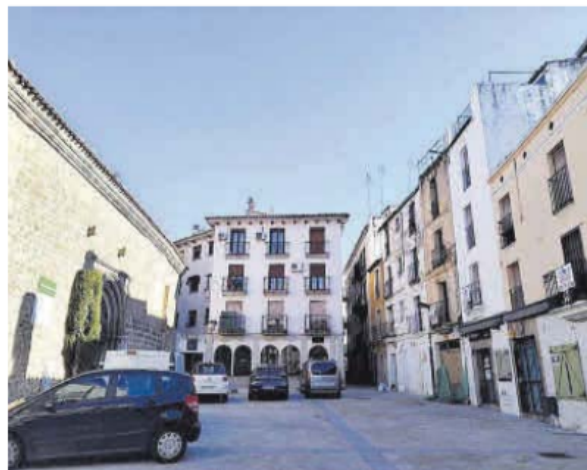
Plaza de San Martín, con edificios de viviendas.
